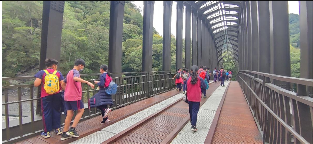
前往奧萬大吊橋，途中經過新型的鋼橋。
